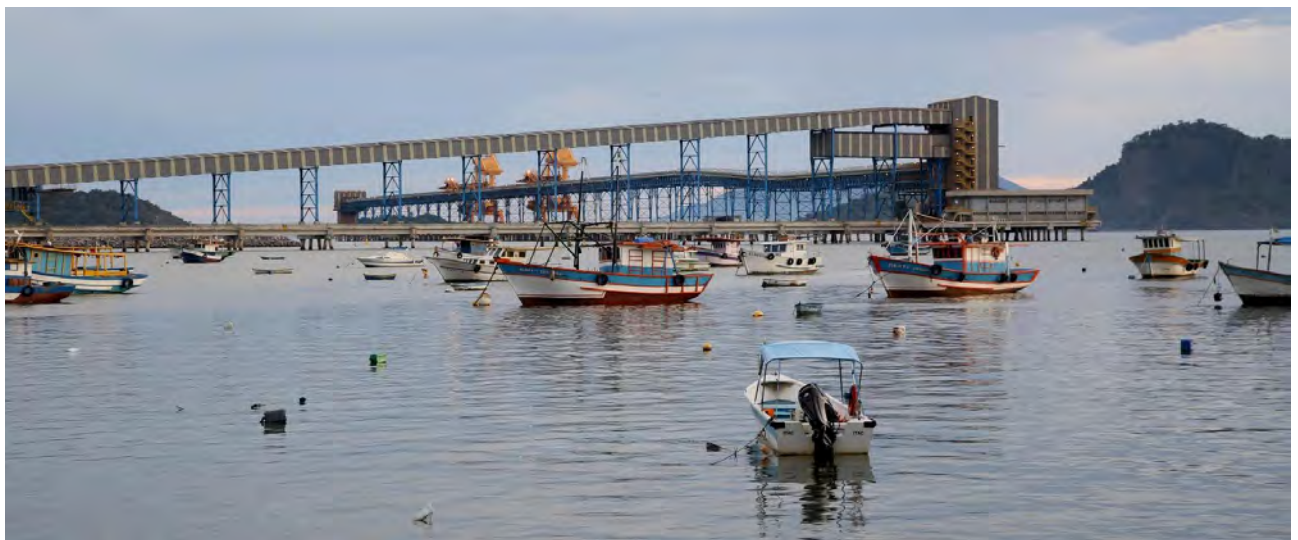
Foto da equipe do PEDUI, durante visita aos municípios da RMRJ, que evidencia conflitos na paisagem de Itaguaí
