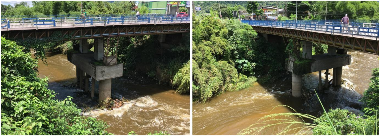
Figura MS 13.A - Fundações expostas de ponte sobre o Rio Guapimirim (Fotos – Toiz Vidaurre)
